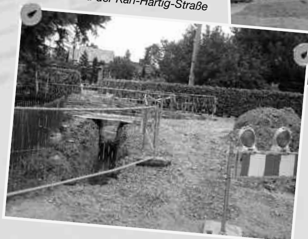
Gemeinschaftsmaßnahme mit dem ZWA: Ausbau der Karl-Hartig-Straße
